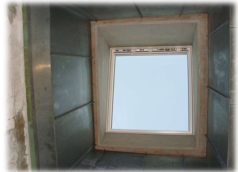
Schließung einer bestehenden Flachdachöffnung
